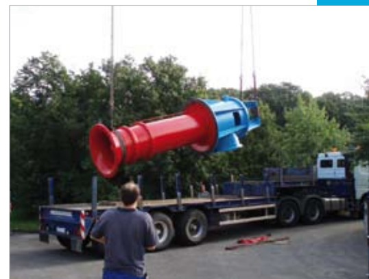
Wechsel einer Hochwasserpumpe
