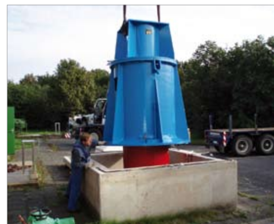
Wechsel einer Hochwasserpumpe
