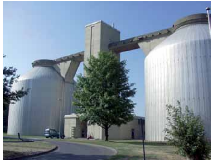
Faultürme KW Monheim
