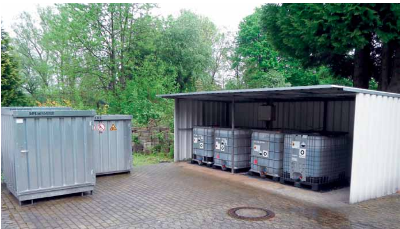
Fällmittel- und Gefahrstofflager KW Düsseldorf
