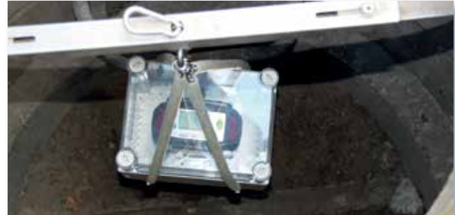
Gaswarngerät bei Messung im Kanal
