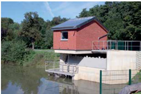
Auslaufbauwerk und Betriebsgebäude Hochwasserrückhaltebecken Goldberger Teich
