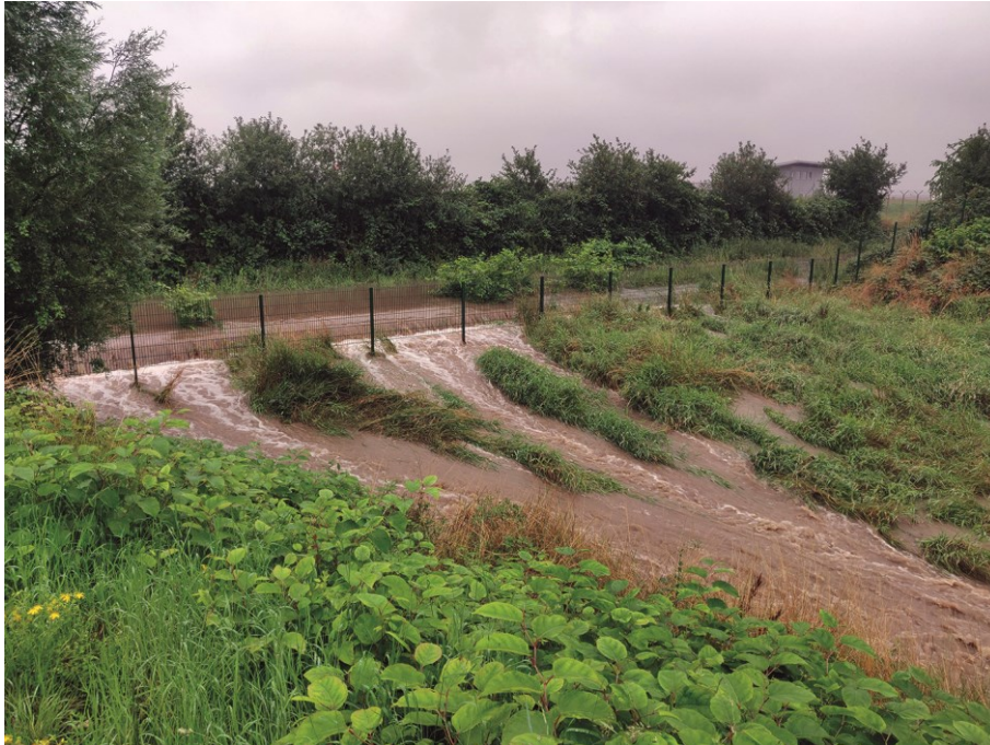
HRB Kalkum - ablaufendes Wasser
